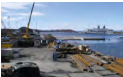
Bjørvikatunnel I Oslo, Norwegen
