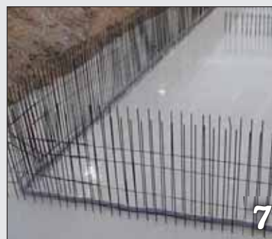
Sicura penetrazione nel calcestruzzo, max. metà larghezza della lamiera
