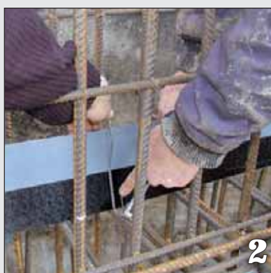
Montaggio sull'armatura con le staffe di posa
