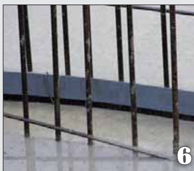
Sicura penetrazione nel calcestruzzo, max. metà larghezza della lamiera
