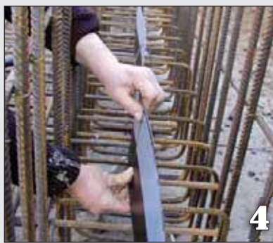
Sovrapposizione e fissaggio con staffe di montaggio
