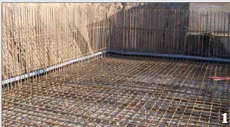
Prima del getto di calcestruzzo, rimuovere la carta siliconata inferiore.
