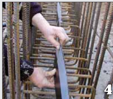
Recouvrement avec des goupilles de sécurité
