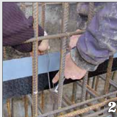
Montage avec étrier de pose sur l'armature
