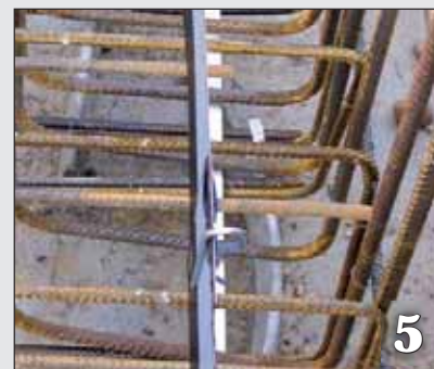
Recouvrement avec des goupilles de sécurité
