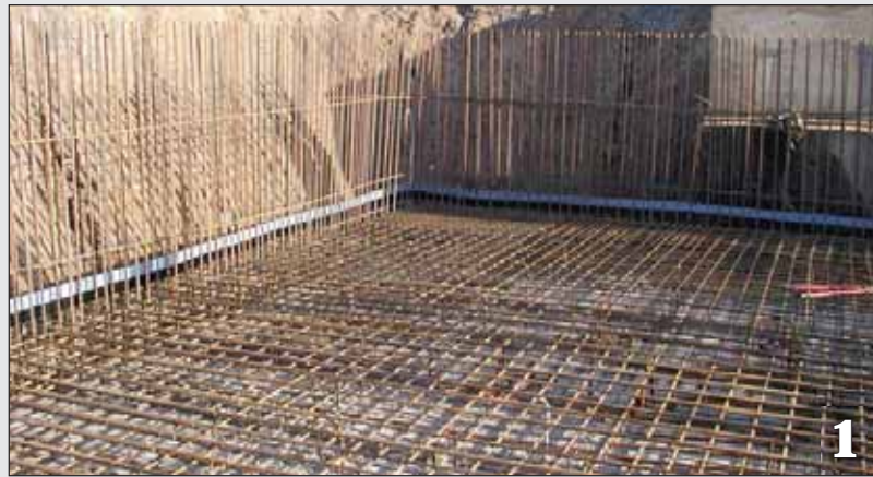
Avant le bétonnage, retirer le papier en silicone inférieur.
