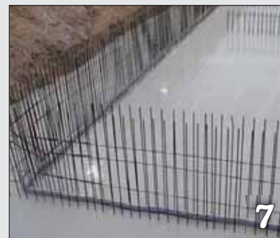
Intégration fiable dans le béton, au max. la moitié de la largeur de la tôle
