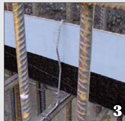
Montage avec étrier de pose sur l'armature
