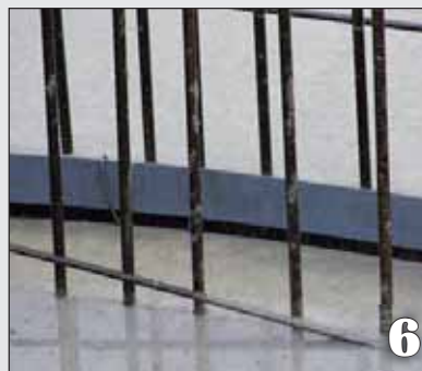
Intégration fiable dans le béton, au max. la moitié de la largeur de la tôle
