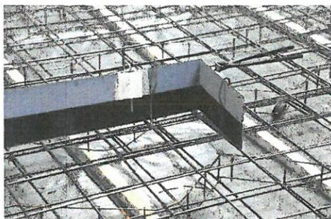
Den Stoß mit einer mitgelieferten Stoßklammer sichern und die Schutzfolie wieder auf die Spezialbeschichtung zurückschlagen.
