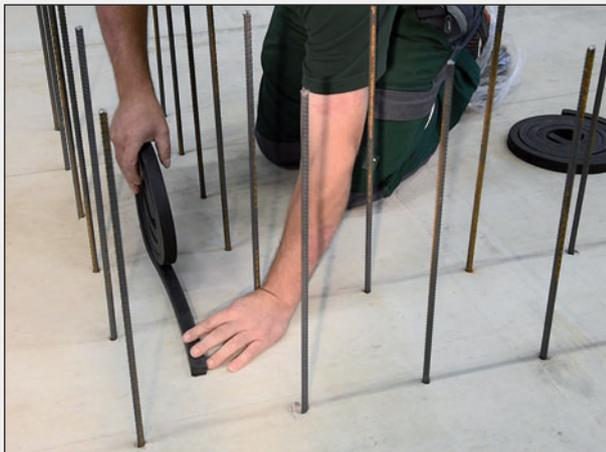
Srotolare il nastro ad espansione all'interno dell'armatura (almeno 8 cm di copertura in calcestruzzo, montaggio all'interno dell'armatura).
