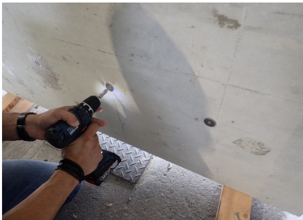
Bild A3-5 Verschrauben einer Stopper Screw covered
