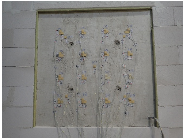
Bild A3-7 Blick auf die brandabgewandte Seite zum Start der Prüfung – 1. Minute
