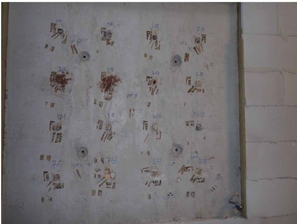
Bild A3-19 Ansicht des Probekörpers von der brandabgewandten Seite nach der Brandprüfung
