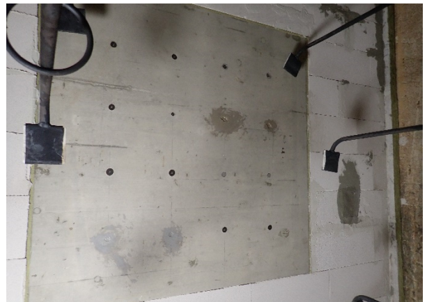
Bild A3-6 Fertig eingebauter Probekörper von der brandzugewandten Seite
