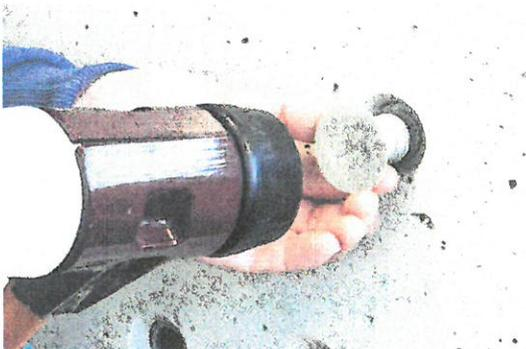
Der **STOPPER maxi** wird mittels einem Hartgummihammer ( Gewicht 1500 – 2000 g ) mit einigen festen Schlägen eingeschlagen.
