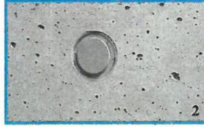
Verschluss Mauerstärke mit Dichtlippe
