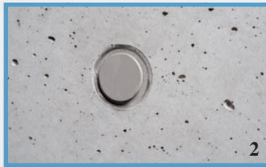
Obturation du tube distanceur avec lèvres d'étanchéité
