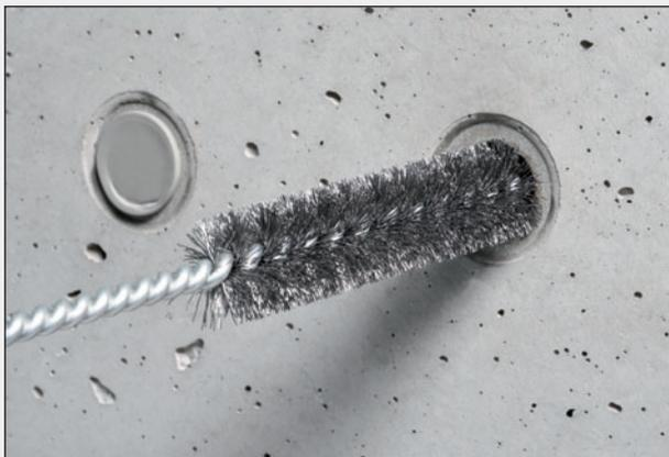
Les tubes distanceurs encrassés doivent être nettoyés avant l'installation du bouchon STOPPER.
