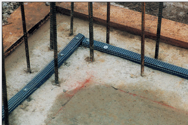
Pose avec grille de fixation et clous
