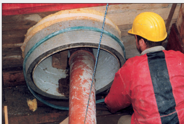
Étanchéité du tuyau
